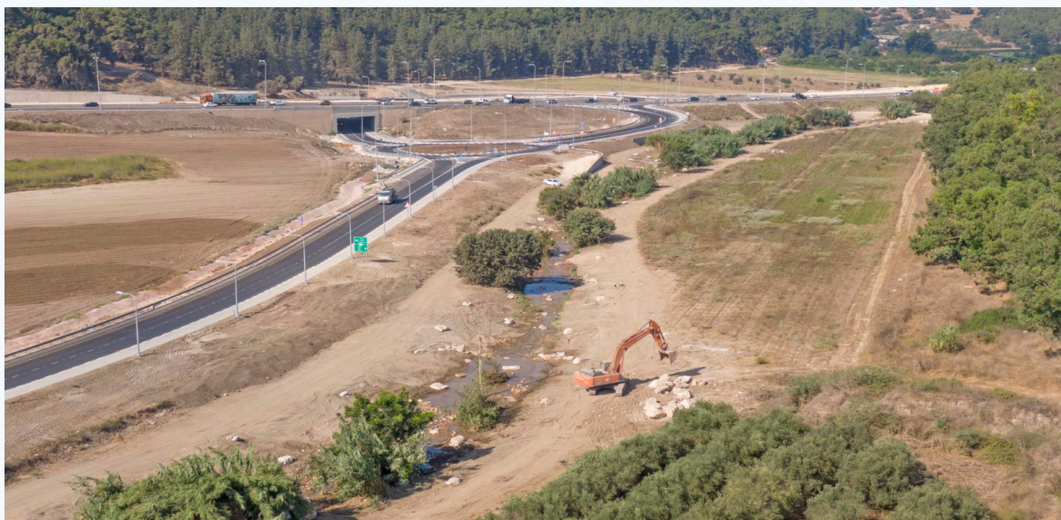
חתך נחל ציפורי אחרי ביצוע העבודות – גדות מתוננות והשבת הנחל למצבו ה"טבעי"
