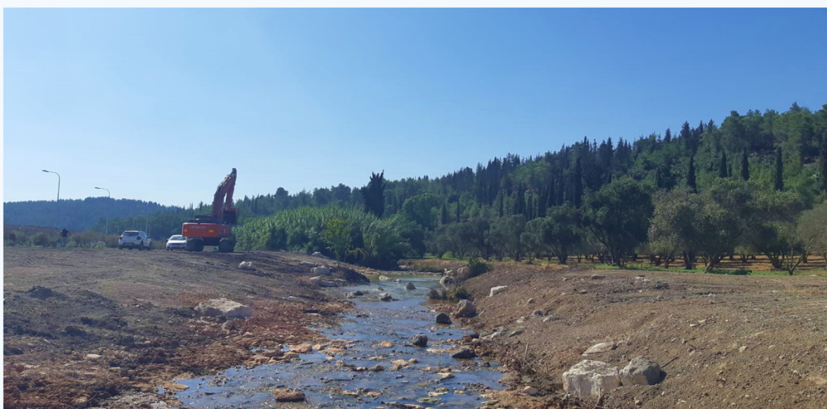
חתך נחל ציפורי אחרי ביצוע העבודות – גדות מתוננות והשבת הנחל למצבו ה"טבעי"
